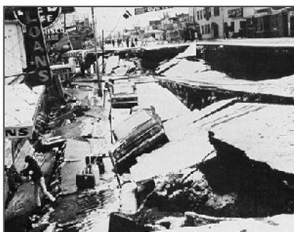
FIGURE 2 - ONE SIDE OF THIS ANCHORAGE STREET DROPPED DRASTICALLY DURING THE 1964 GOOD FRIDAY EARTHQUAKE.
